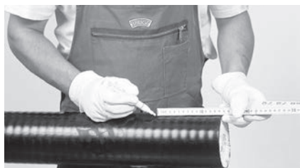
1 Mantel im Abstand (x,y,z) +1 cm vom Rohrende anzeichnen.
