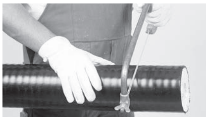
2 Mantel mit Säge durchtrennen.
